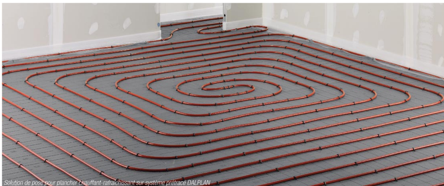
Solution de pose pour plancher chauffant-rafraîchissant sur système prétracé DALPLAN
