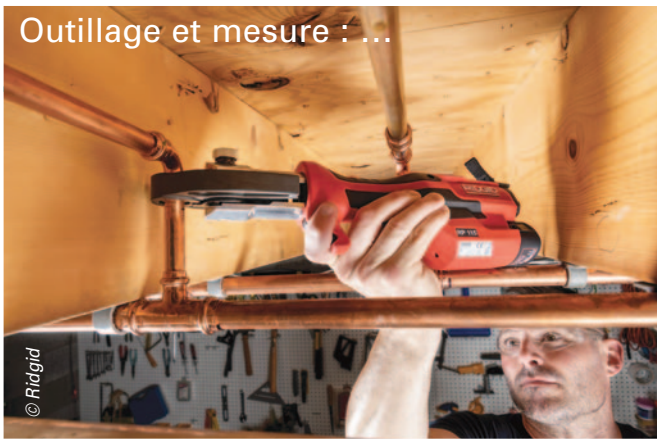
Voici la sertisseuse RP115 : la plus compacte au catalogue Ridgid.
